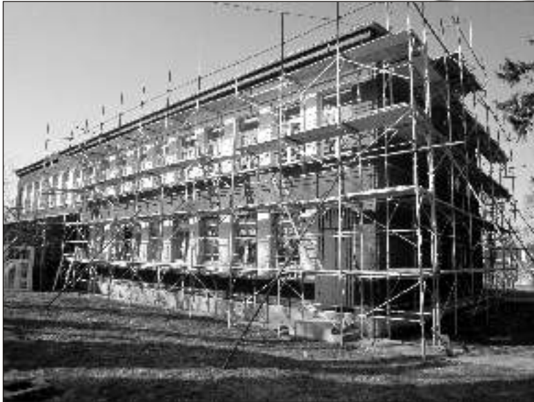
Realizácia projektu Energetická efektívnosť vo verejných budovách - budova OcÚ
