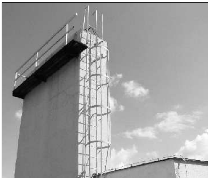
Opravovaný komín ZŠ
