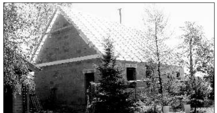
Environmentálne kultúrno-spoločenské a športové centrum. Poľovníci sa prejavili ako veľmi dobrí stavbári.
