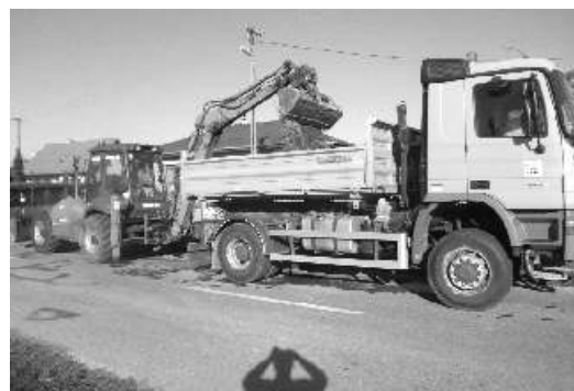
Regionálna správa a áúdržba ciest Nitra rekonštruovala štátne cesty a na Gecovskom prehliabla pricestný rigol.
